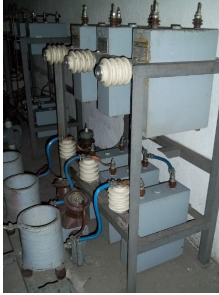
Şekil 4.3 Söküm Öncesi Kapasitörler
