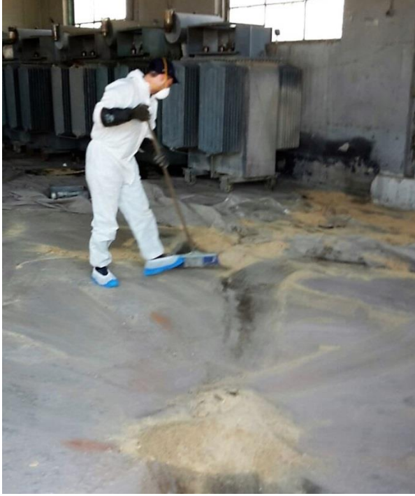
Şekil 3.6 Eski bir Trafoda Sızıntı (Üretim Yılı: 1975)
