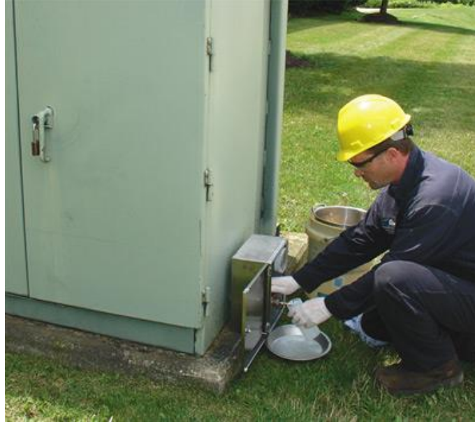
Şekil 2.7 Trafonun Vanasından Örnek Alma
