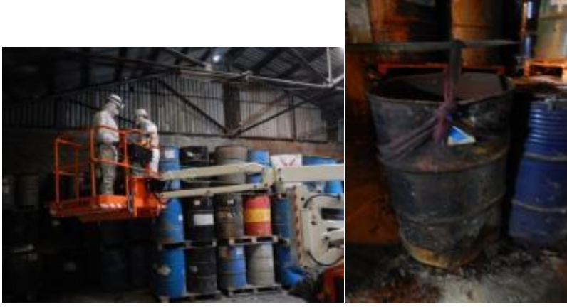
Şekil 5.3 Varillerin bantlanması (solda). Varillerin tek tek tartılması ve transferi (sağda)
