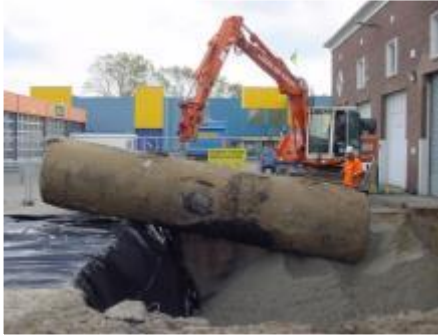
Toprak Kazısı (Kaynağı Kaldırmak)
