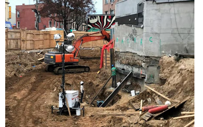
Saha dışına taşıma ve şev destekleme
