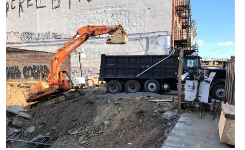
Saha dışına taşıma ve şev destekleme
